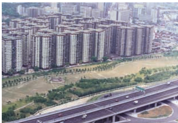
西九龍快速公路按規劃與美孚新邨以 150 米的園景緩衝區分隔開。為符合標準，當局已豎設 3 米高的隔音屏障，以減少美孚新邨的噪音。
