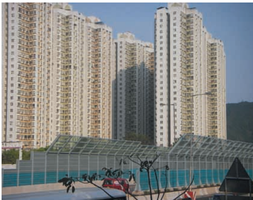
在粉嶺公路加 設隔音屏障
