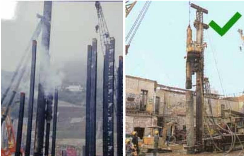
以微型樁取代柴油鑽錘打樁，減少空氣及噪音污染
