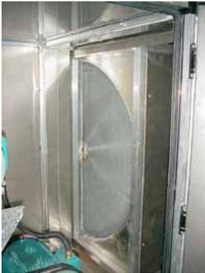
採用旋轉型熱交換器從廢氣回收熱量，
