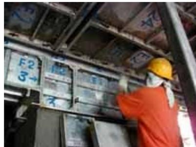
使用系統式鋁模以取代傳統的木板板模
