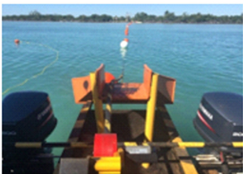
圖2.1b 工程所用的典型主要設備／工具照片 (2)
