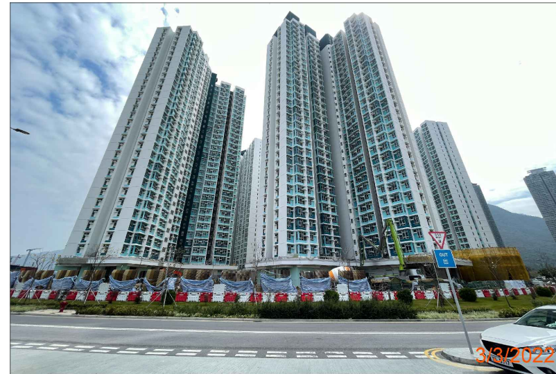
VSR5 (RESIDENTIAL VSR OF YU NGA COURT)
