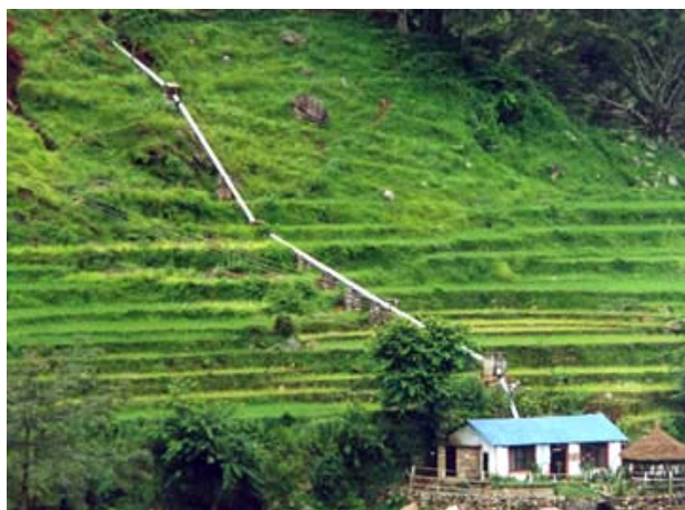
乡村区域的电力屋 443
