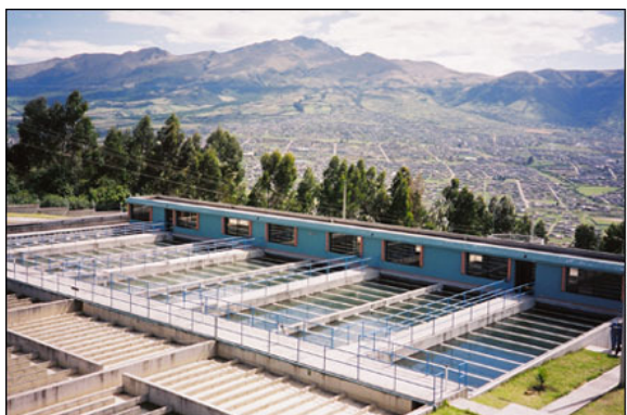
位于 Southern Quito 的新处理厂 383
