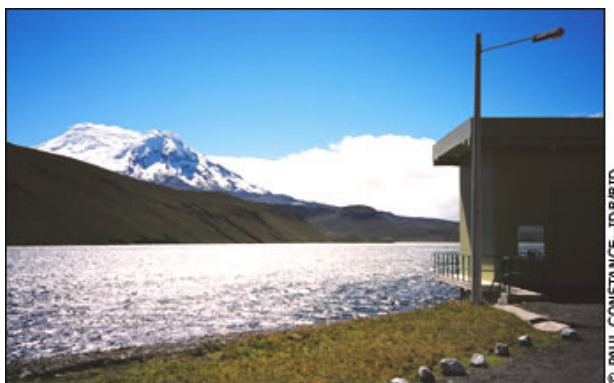
位于 Mt. Antisana 的一个小水库 384
