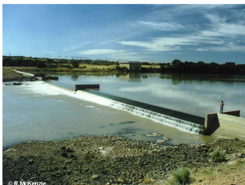
位于 Marksdrift 设于 Orange River 的泵站 332
