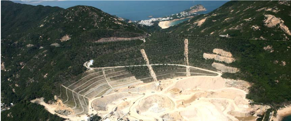
進行中的石澳石礦場復修工程
