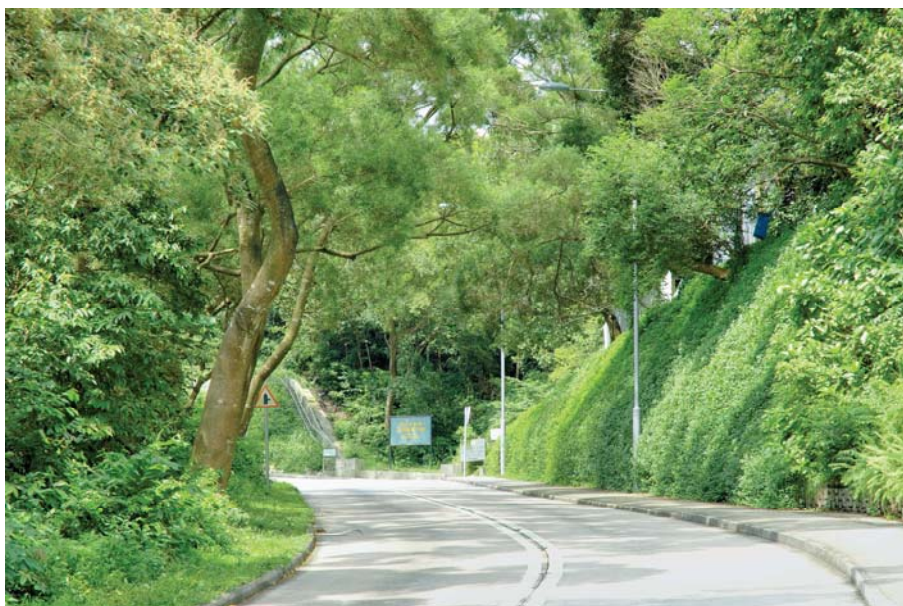
大嶼山嶼南道經防止山泥傾瀉計劃鞏固的人造斜坡的綠化工作
