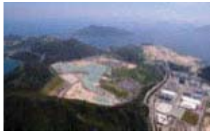
新界东南堆填区
