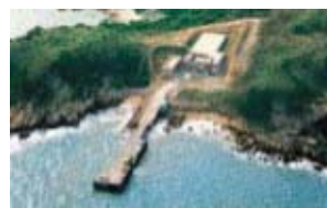
小鴉洲低放射性廢物貯存設施
