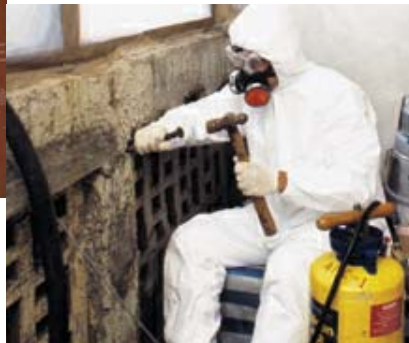
受過訓練的工人正在清除含石棉物料
