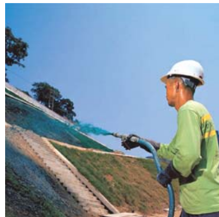
屋邨斜坡的噴草工程
