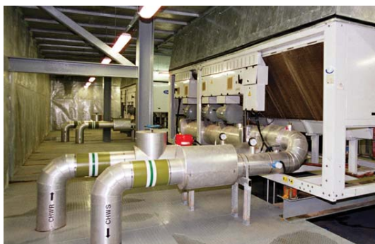
風冷式冷凍機加上隔音圍封，並裝有減聲器
