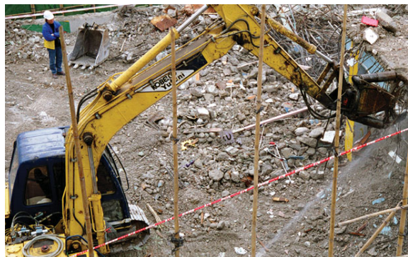
液壓混凝土壓碎機大大減低拆卸工程所產生的噪音
