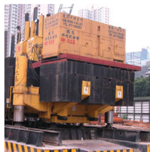
2002年在元州邨重建計劃的地盤試用油壓式送樁法，有效減低噪音，而且符合成本效益
