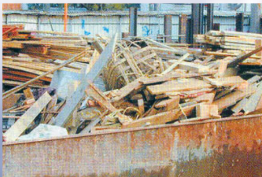
在地盤現場把拆建廢料分類
